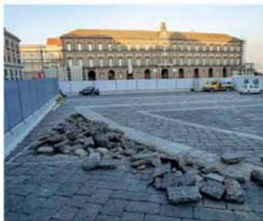
Cantiere Piazza Plebiscito con il basolato rimosso per i lavori del metrò
